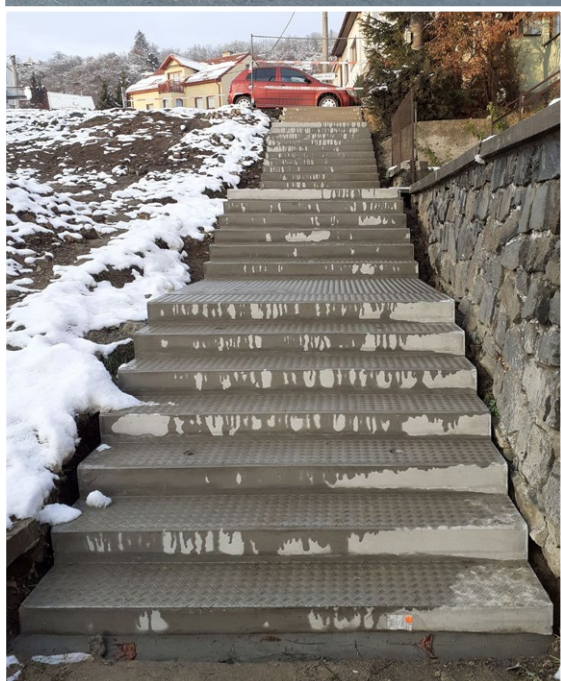
NOVÉ SCHODY V SERPENTINÁCH
